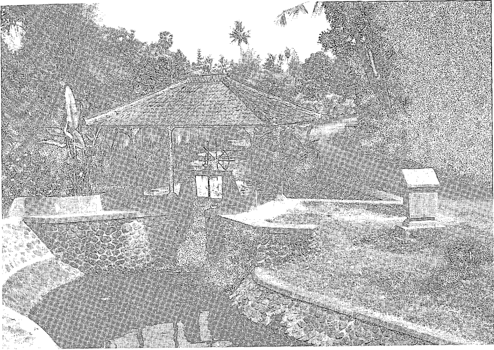
河川からの取水堰（屋根付きはバリ独特の様式）
