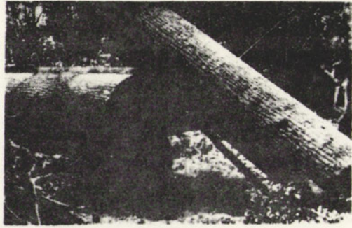
G-4 谷間から丸太を引き上げ、3本目の丸太を積むところ
