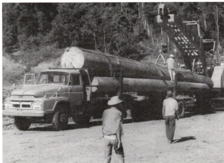
積荷作業 積荷はローダー2台（石川 島コーリング）を使い、氷 バサミのような tong で丸 太をはさみとる。トレーラ ーは特注のポールトレーラ ー（いすず）。丸太長は約 10m、日本市場で好まれた 太くて長いものの選定を指 示した。
